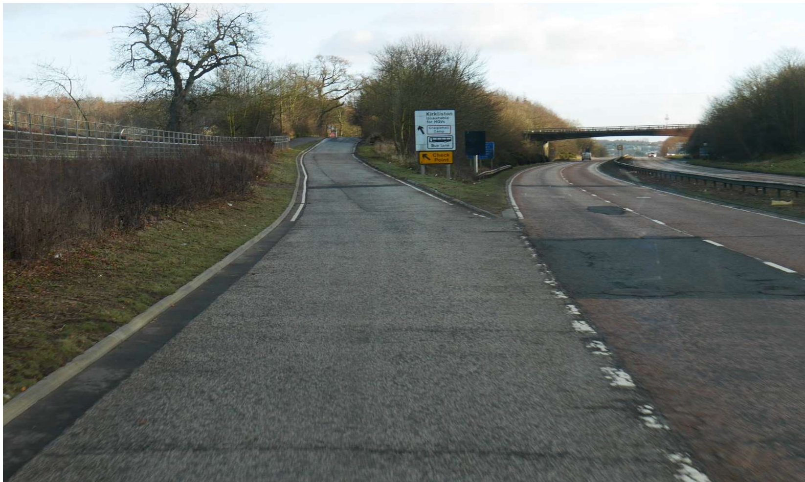
Izvoz na lokaciji Q2, ki v konici služi tudi kot rumeni pas.
